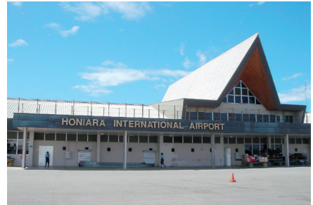
日本の援助によりつくられた国際空港ターミナル
